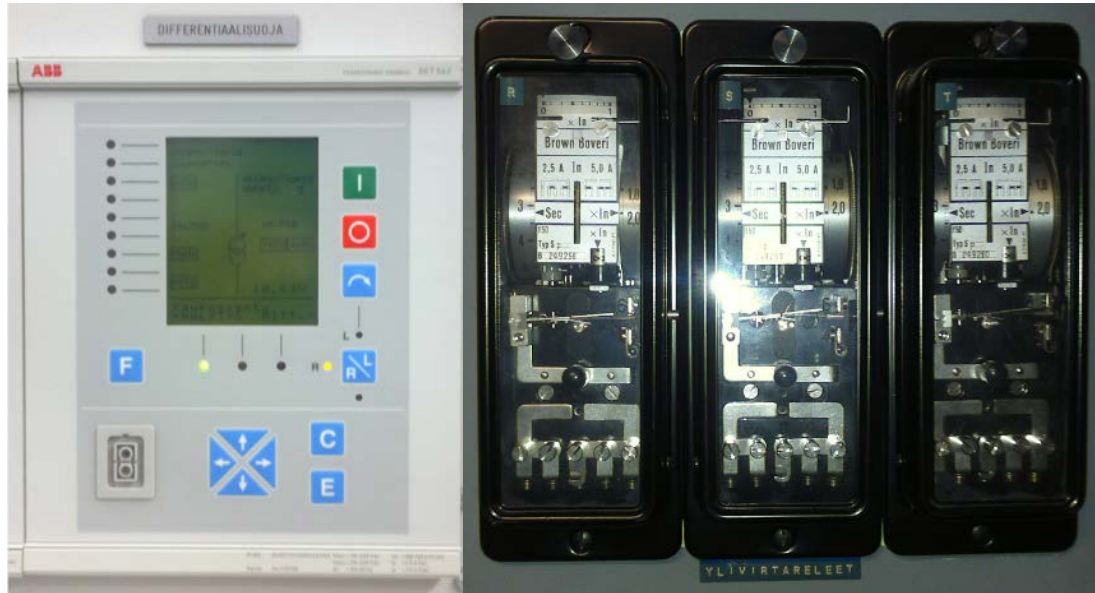
KUVA 16. Nykyaikainen digitaalirele KUVA 17. Sähkömekaanisia releitä
