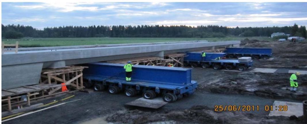
Kuva 5. 3kpl 3 metriä leveät SPMT-yksiköt. (Suonteen sillan siirto 2012. Savon Kuljetus Oy.)
