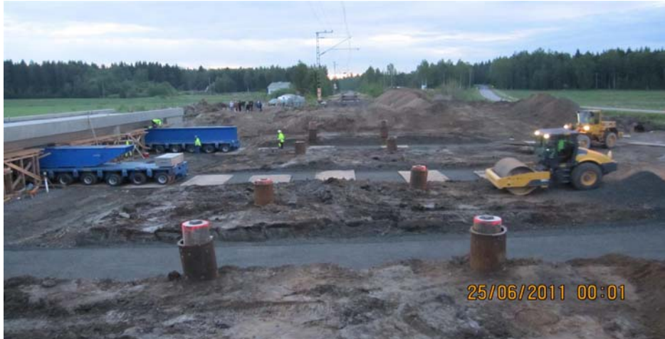
Kuva 1. Sillan siirtoradan valmistelua. (Suonteen sillan siirto. Pöyry Oy 2011)
