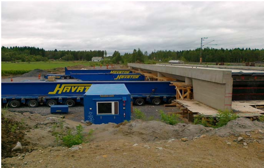
Kuva 7. Suonteen rautatietasoristeyksen korvaus uudella jatkuvalla teräsbetonisella ulokelaattasilalla. Sillan siirtoa valmistellaan. (Suonteen sillan siirto. Savon Kuljetus Oy 2011.)
