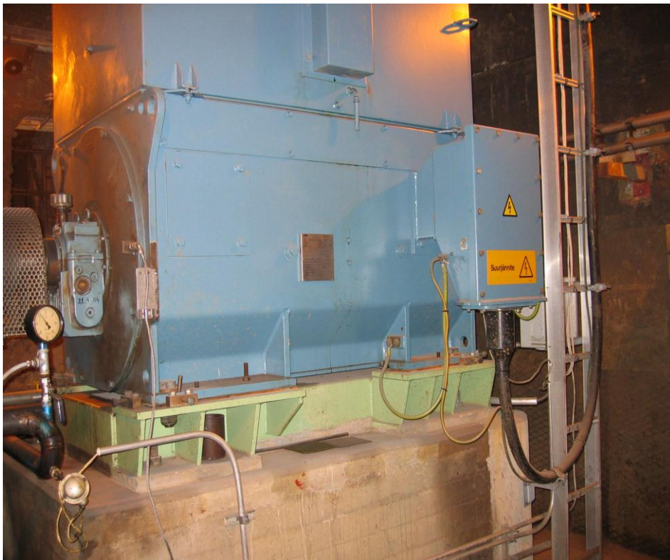
Kuva 4. Kompressorin 983.07 moottorin teho on 1400kW.
