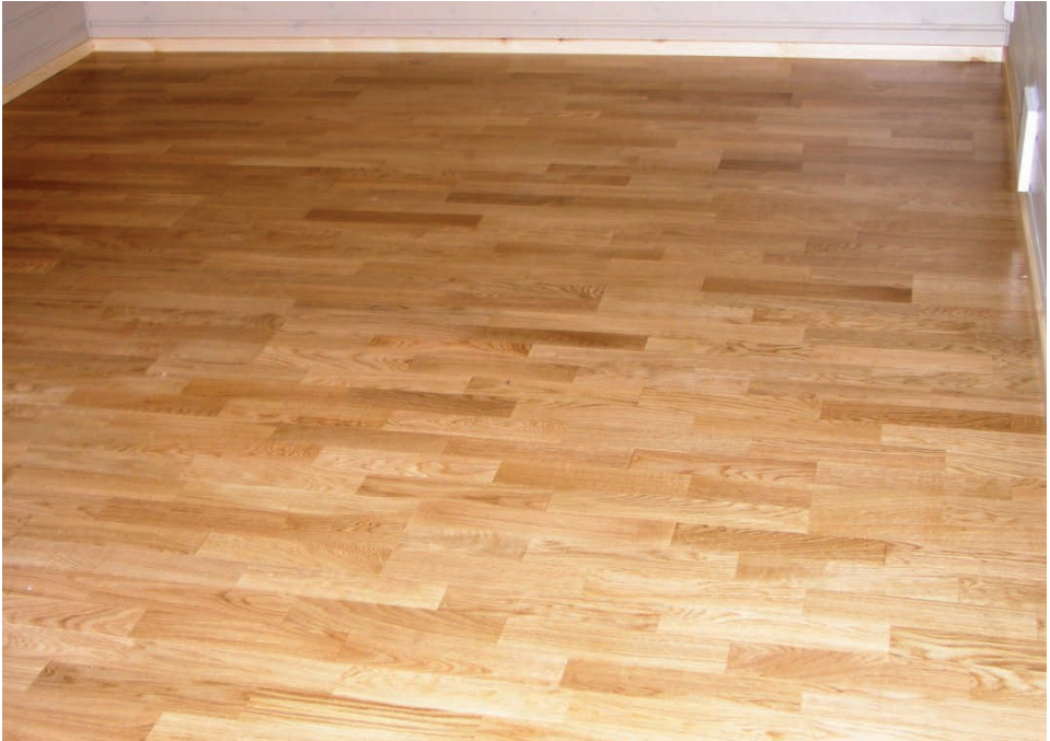
Kuva 3. Makuuhuoneen saarniparketti asennettuna kesäkuussa 2009.
