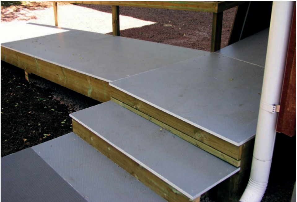
Kuva 9. Invaluisika ja osa vanerikäytävää asennettuna kesäkuussa 2009.
