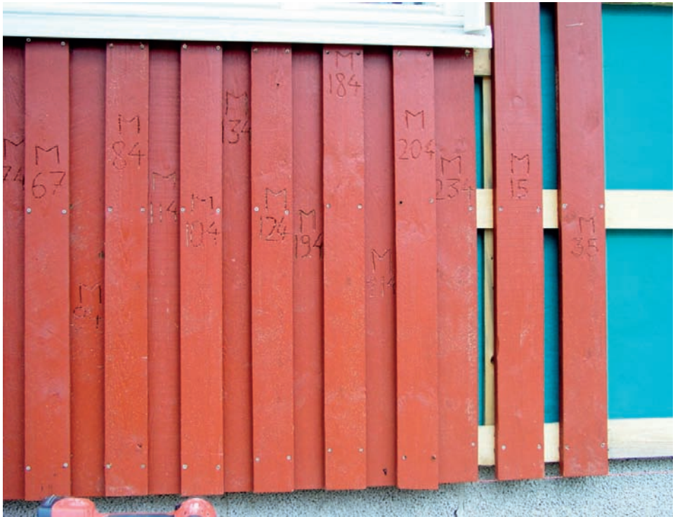
Kuva 5. Ulkoverhouksen asennus huhtikuussa 2009.
