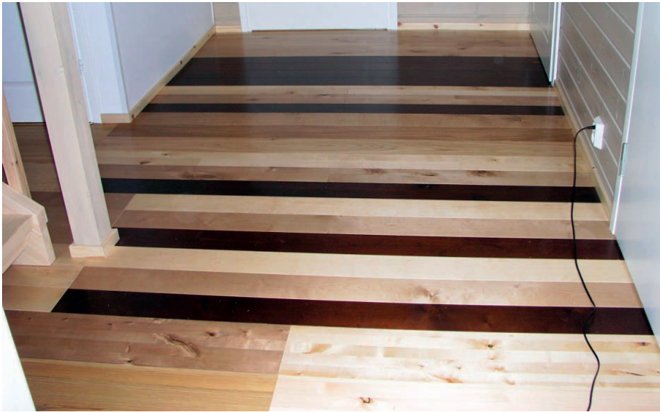
Kuva 2. Ala-aulan parketti asennettuna kesäkuussa 2009.
