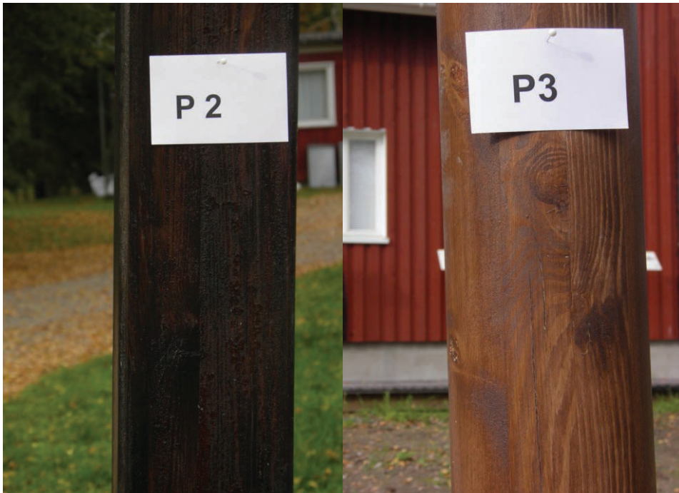
Kuva 30. Pylväs nro 2, mäntyöljyä tihkunut pintaan. Pylväs nro 3, hieman mäntyöljyä tihkunut pintaan, joitakin halkeamia.
