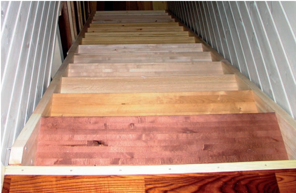
Kuva 4. Portaat asennettuna kesäkuussa 2009.
