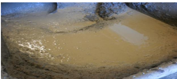
KUVA 17. RB3-notkistimella tehty betonimassa
