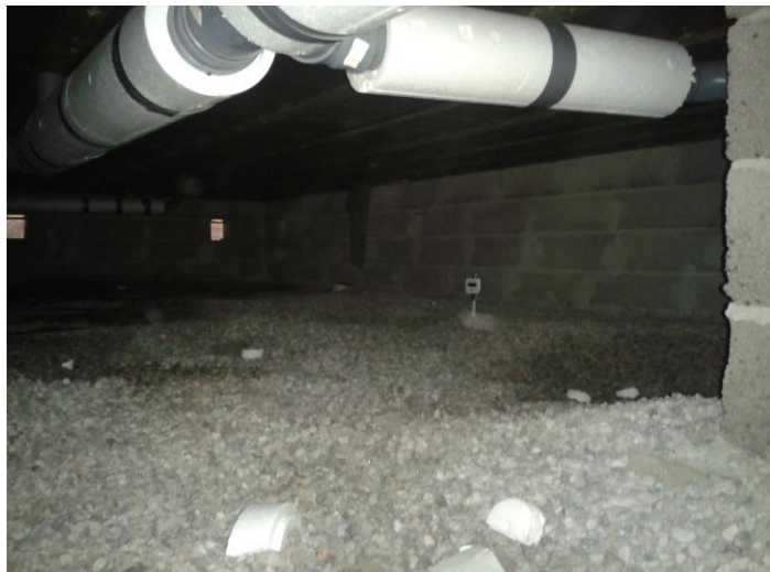
Kuva 5 630/08 toinen anturi lähempänä ulkoseinää.
