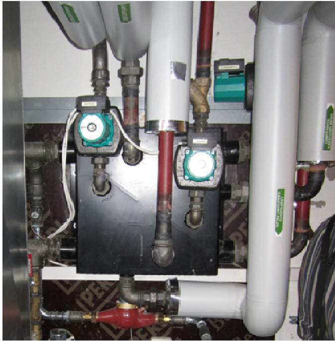
KUVA 19. Thermolink-virtausjakoyksikkö
