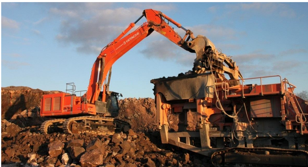
Kuvio 4. Tela-alustainen kaivinkone syöttämässä track-murskaa
