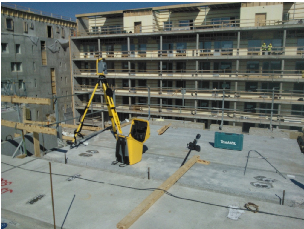
Kuva 3. Takymetri asemoituna rakenteilla olevan rungon ylimpään kerrokseen. (Matti Väisänen)
