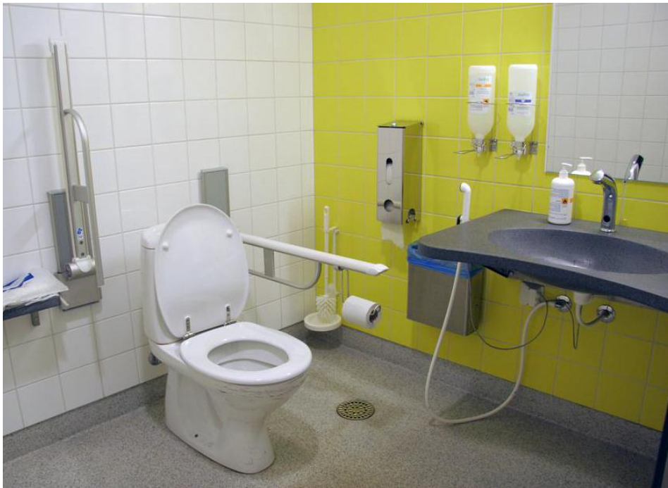
Kuva 15. Vapaata tilaa pyörätuolia varten (Helsinki kaikille projektista)
