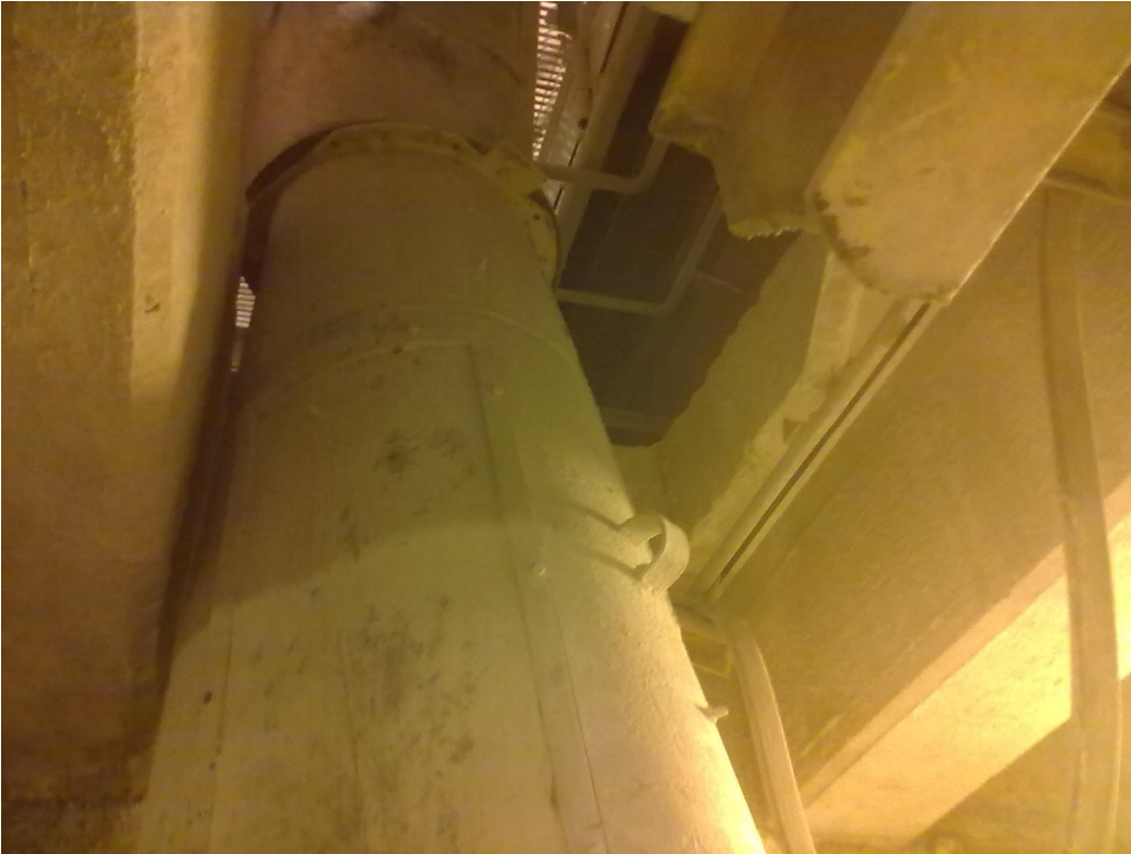
KUVA 22. Aukko lattiatasossa. (kuva Anssi Hakkarainen)
