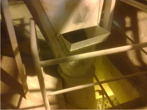
KUVA 11. Apatiittisiilon lattiataso. (kuva Anssi Hakkarainen)
