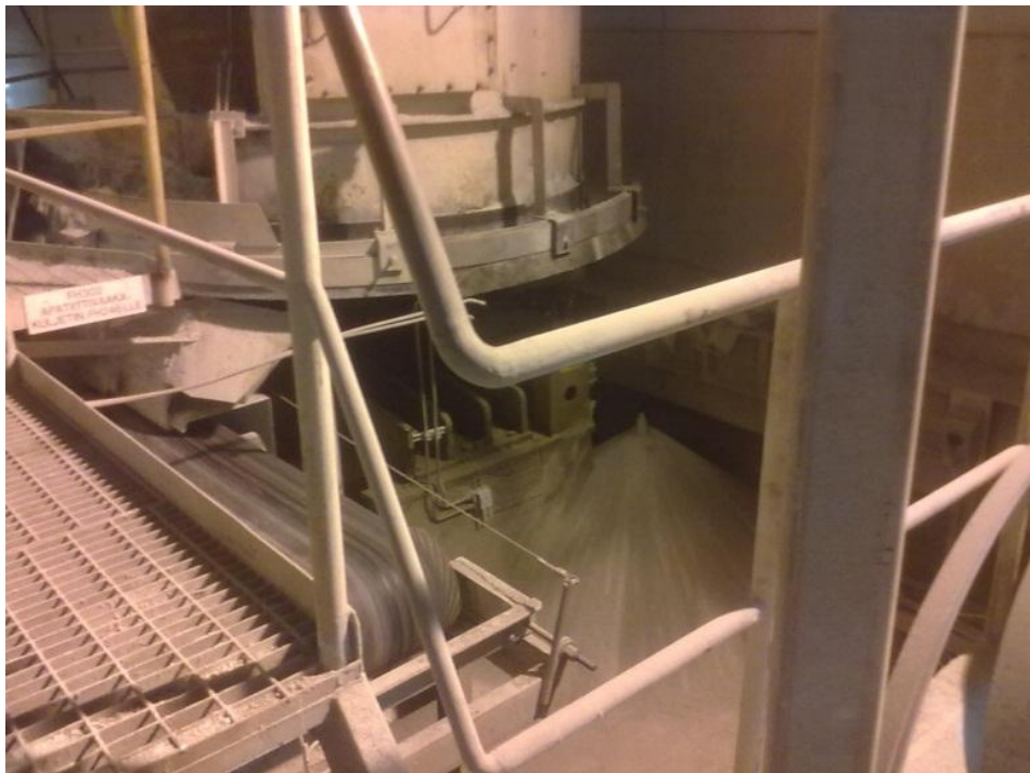
KUVA 10. Apatiittisiilo lattiataso. (valokuva Anssi Hakkarainen)
