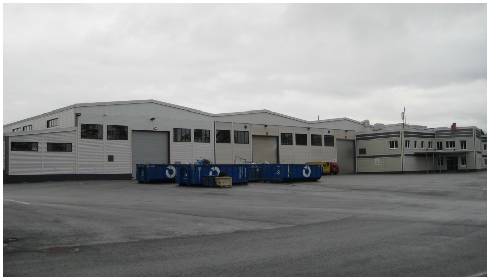
Kuva 2. Kuvassa kauempana on toimistorakennus, seuraavana levytyöosasto, sitten kaksi hitsausosastoa ja viimeisenä lähettämön varasto
