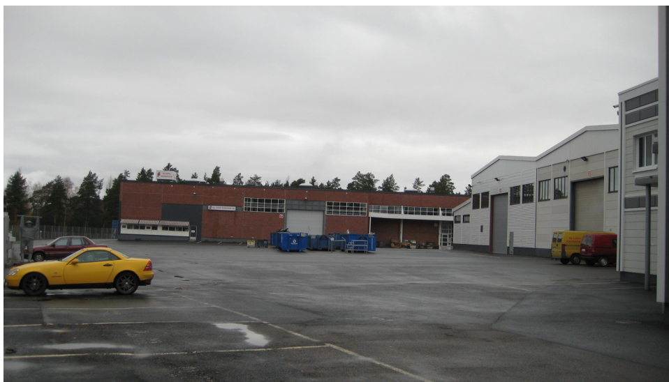
Kuva 3. Kuvassa kauempana on puristinosasto ja sivussa kuvassa 2. mainitut osastot
