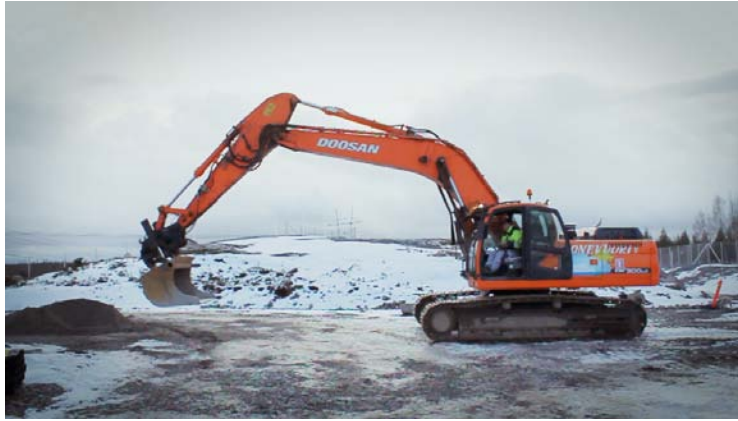
KUVA 23. Konevuori Oy:n kaivinkone Anttilan sähköaseman laajennustöissä tammikussa 2012 (Viljanen 2012)
