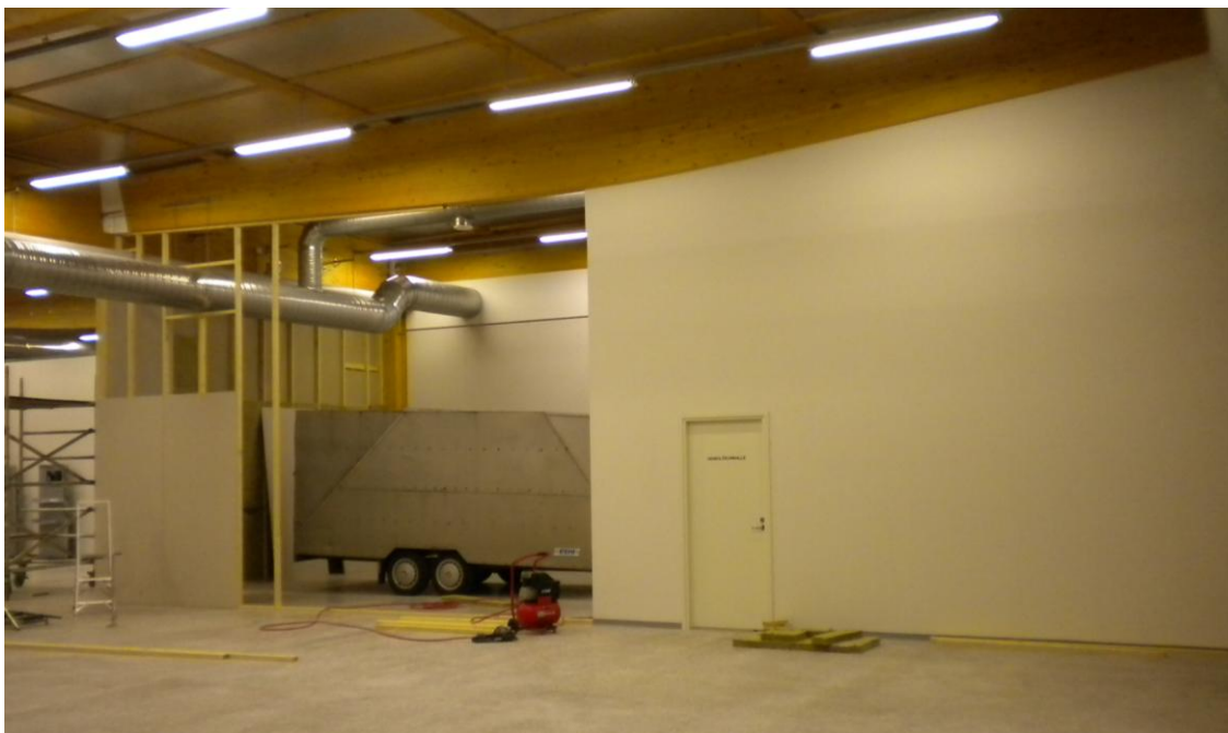
KUVA 2. Huollon laajentaminen rakennusvaiheessa 2010 syksyllä
