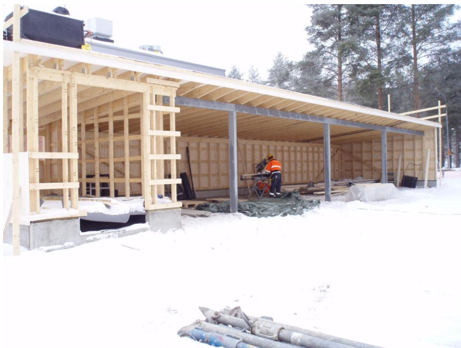
Kuva 9. Vesikattovalmis autokatos. Katos toimii suojana materiaaleille ja työkohteille.
