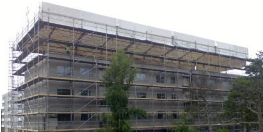
Kuva 3. Kerrostalotyömaalle alumiinisista rakennustelineistä ja ristikkorakenteesta katteesta pystytetty sääsuoja /15/.
