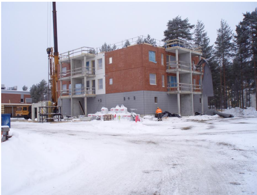
Kuva 22. Kolmannen kerroksen elementit on lähes kokonaan asennettuna.
