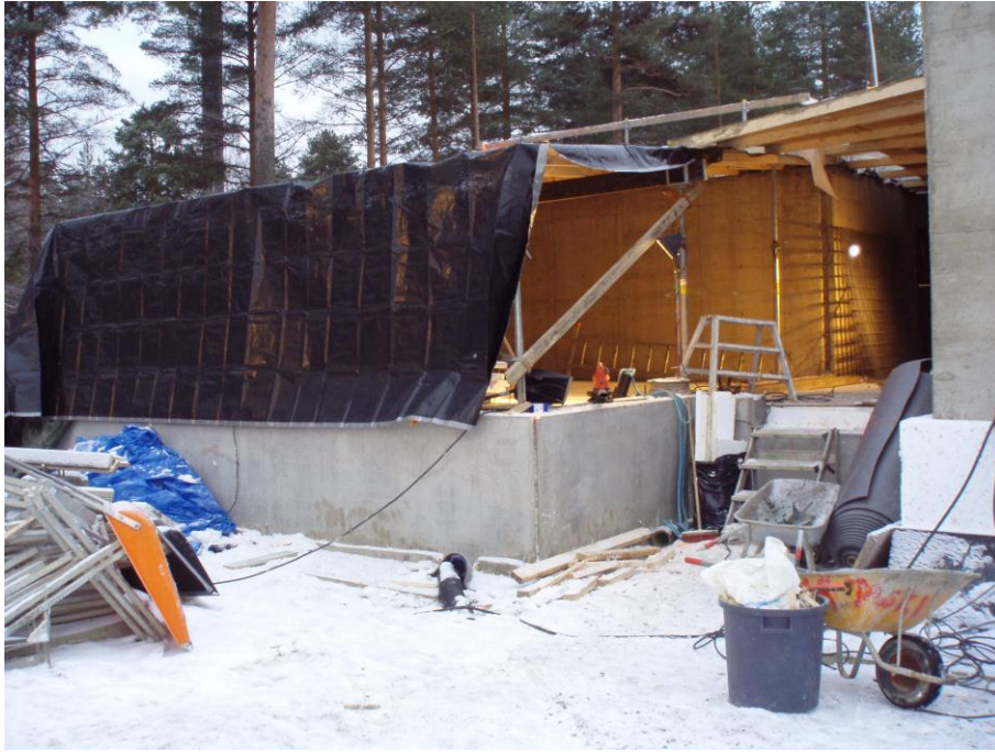
Kuva 11. Lämmönjakohuoneen väliaikainen sääsuoja.
