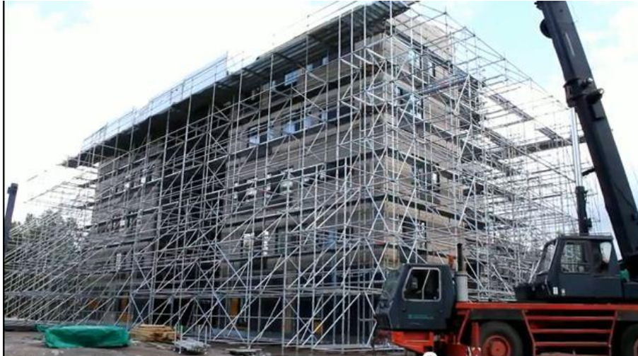
Kuva 5. Puukerrostalon runkorakennusvaiheen sääsuojus Heinolassa vuonna 2011. Rakennustelinepohjaisen sääsuojusratkaisun katetta on siirretty elementtien nostojen ajaksi /17/.
