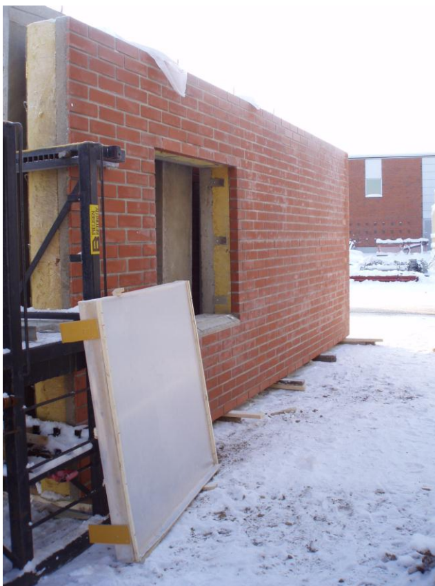
Kuva 12. Ikkuna- ja oviaukkoihin asennettavat muovi-ikkunat.
