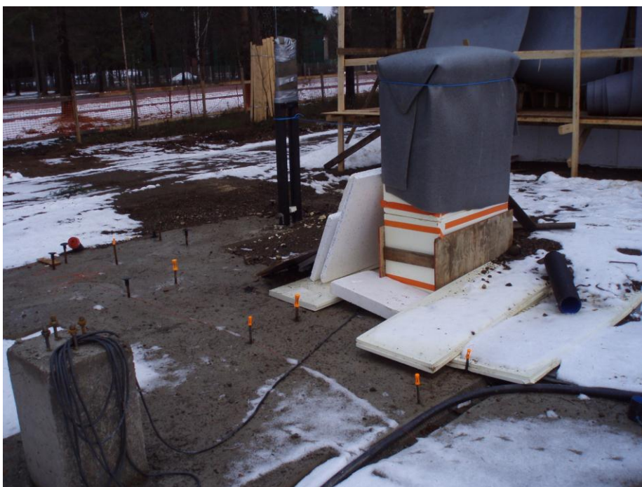
Kuva 20. Käyttöveden tulopisteen eristys.
