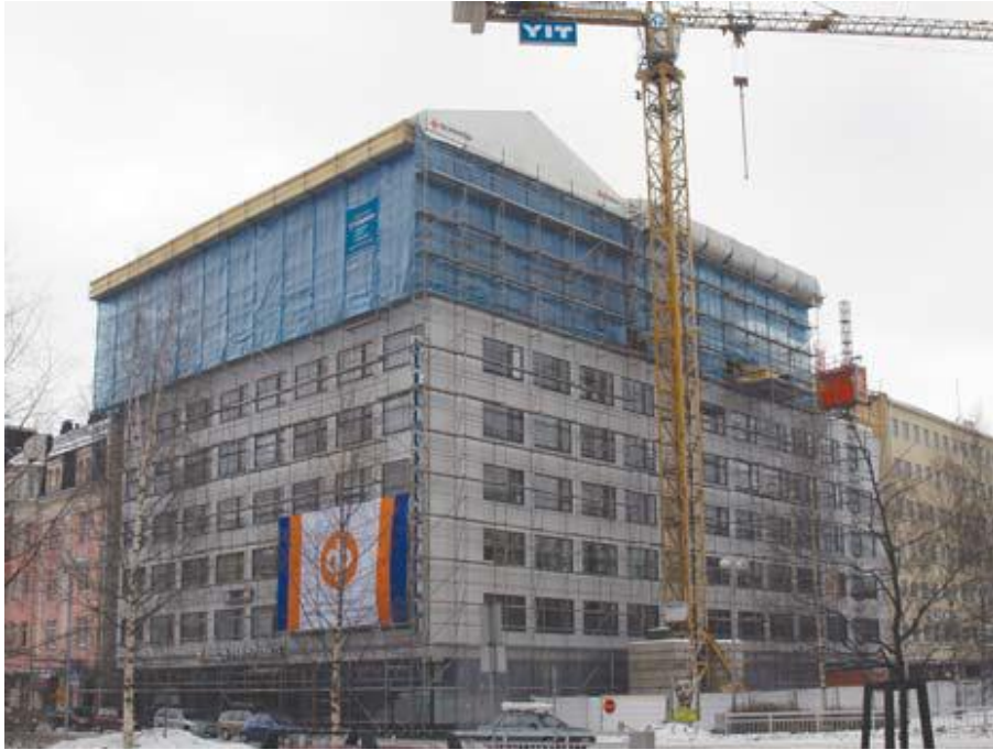
Kuva 4. Rakennuksen lisäkerrosrakentamisen ja kattotöiden ajaksi pystytetty alumiinirakenteinen sääsuoja. Seinät on peitetty valoa läpäisevällä peitteellä. Runkona toimivat rakennustelineet ovat pystytetty maasta asti /16/.
