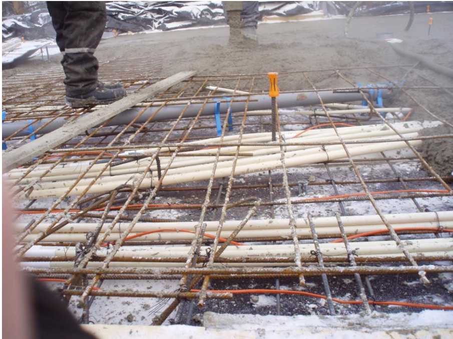
Kuva 17. Kolmannen kerroksen holvin betonivalu. Ulkolämpötila -13 °C.
