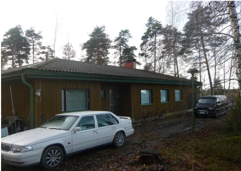
Kuva 11. Talon julkisivu luoteeseen.
