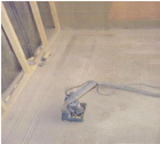
Kuva 15. Betonilattian uritus ja urituskone (Nereus 2011).
