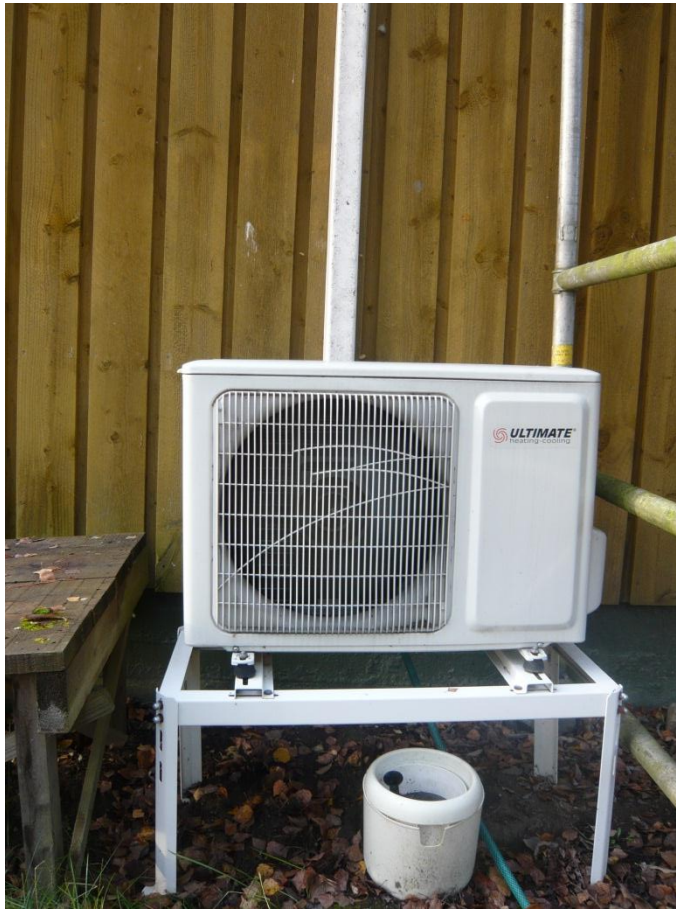
Kuva 12. Ilmalämpöpumppu
