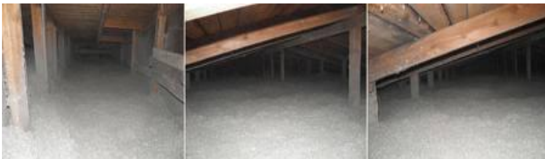
Kuva 9. Yläpohjan lisäeristys puhallusvillalla (Uudenmaanpuhallusvilla).
