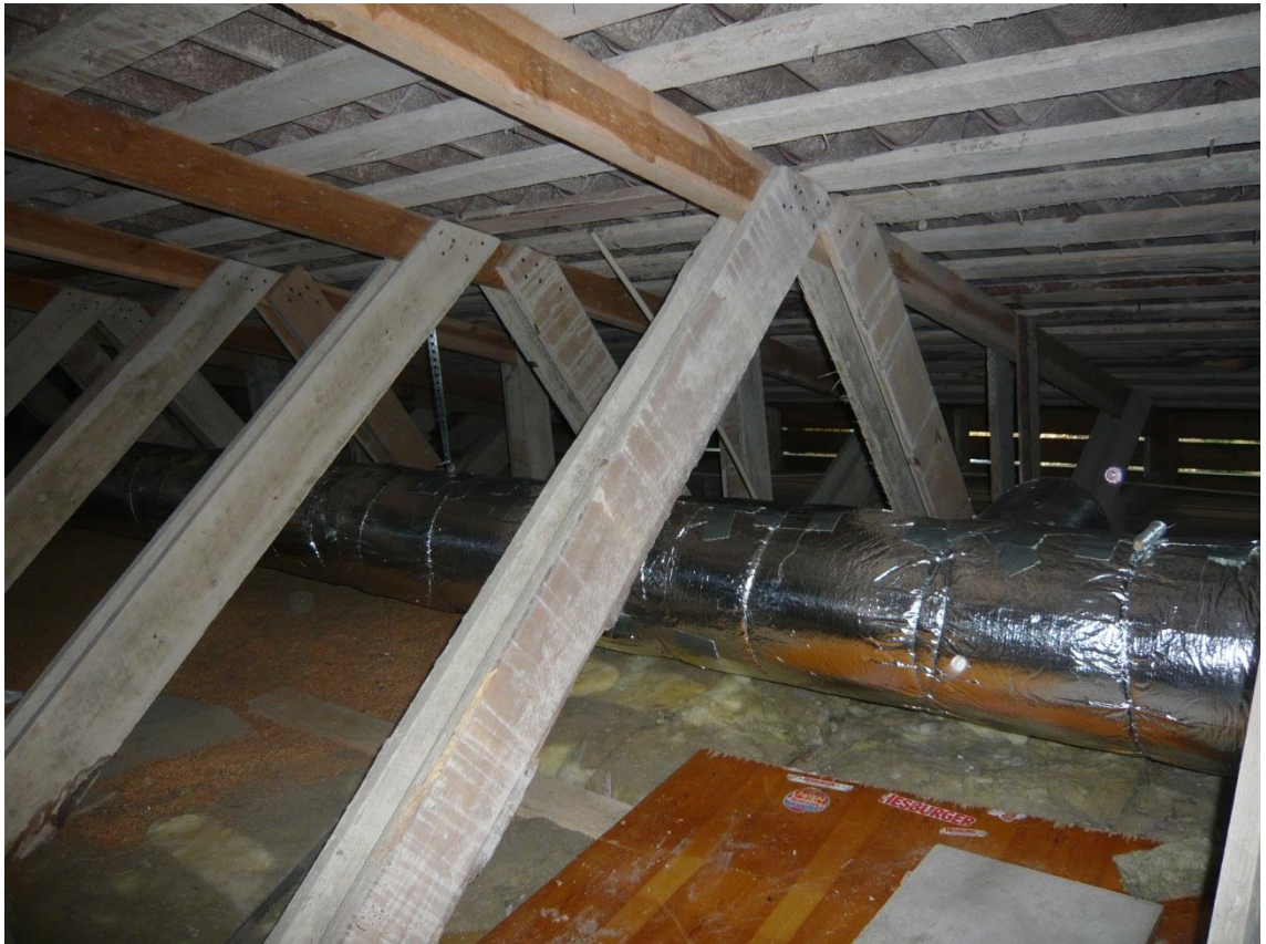
Kuva 13. Ilmanvaihtokanavien asennusta yläpohjassa.
