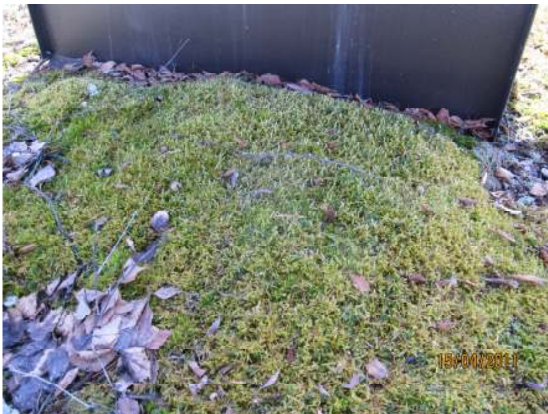
Kuva 36. Katto on kauttaaltaan paksun sammaleen peitossa
