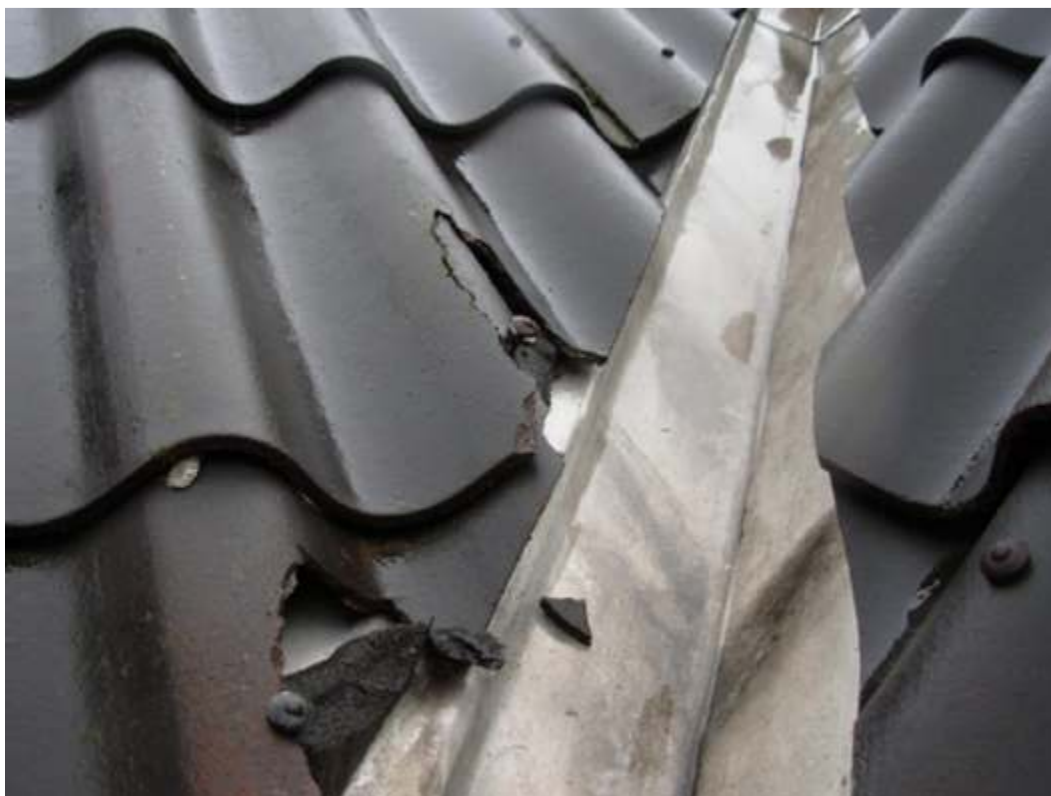
Kuva 7. Lumen ja jään vaikutuksen vuoksi halkeillut sisätaitte
