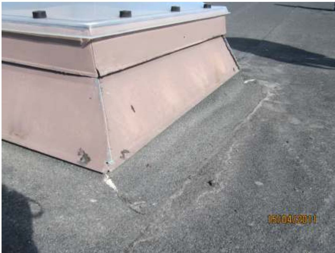
Kuva 22. Kattoikkunan ylösnosto
