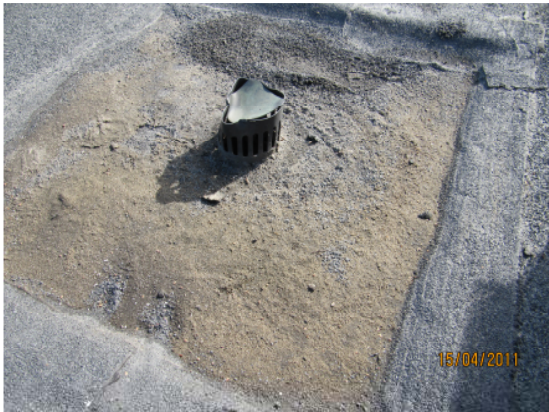
Kuva 21. Kattokaivo asennettu nelion malliseen syvennykseen, jossa on painaamia mihin vesi voi jäädä asumaan
