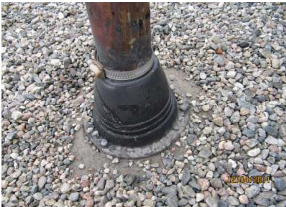
Kuva 10. Läpiviennin tiivistys ja ylösnosto
