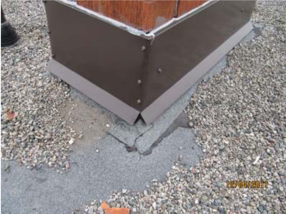
Kuva 12. Piipun juuren ylösnosto
