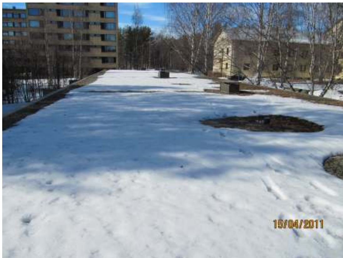
Kuva 38. Katon kallistukset ovat minimaaliset
