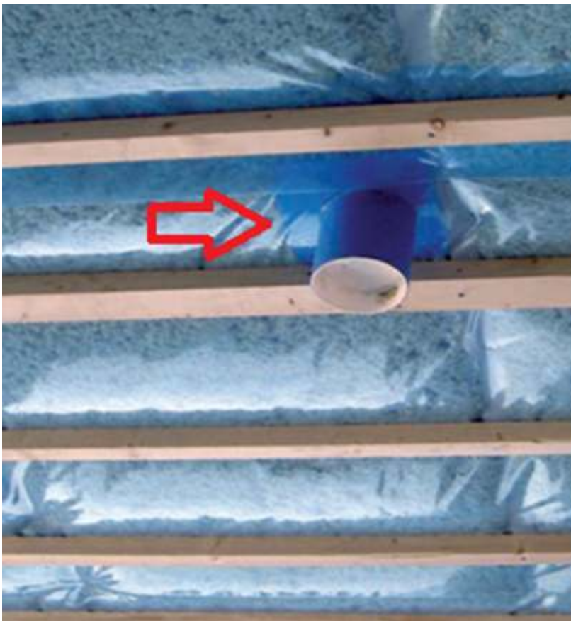
Kuva 1. Höyrynsulun läpivienneissä käytetään läpivientikappaleita (4)
