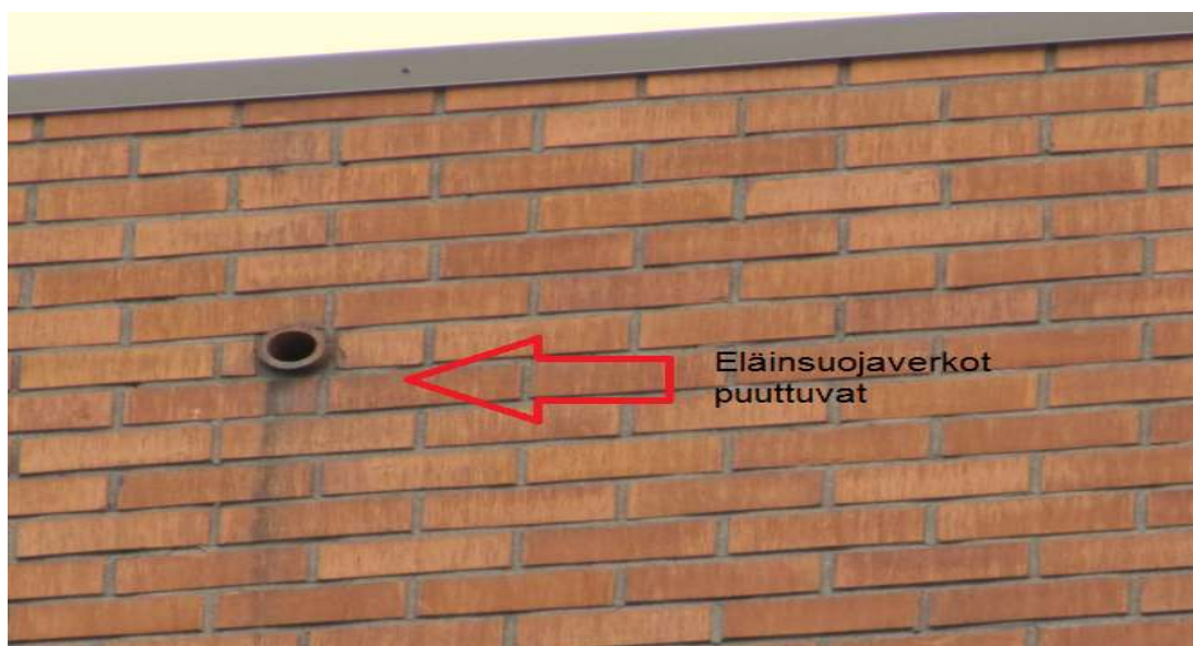
Kuva 17. Eläinsuojaverkoton tuuletusaukko
