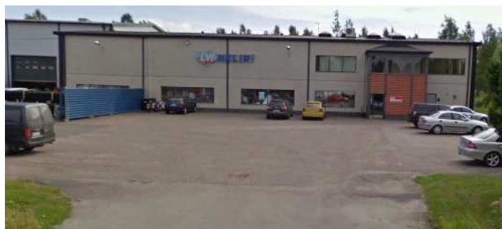
Kuva 1 LVI-Helin Oy pääkonttori
