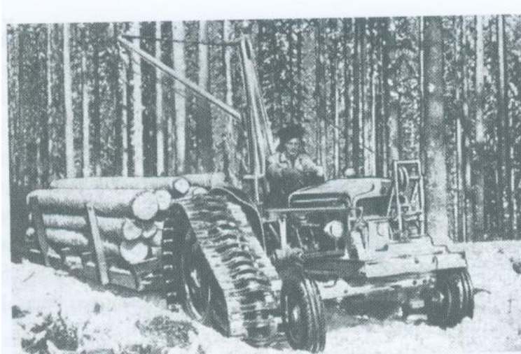
KUVIO 1. Vinssi ja puolitelat asennettuna Fordson-traktoriin (Vilkuna 2002, 34)
