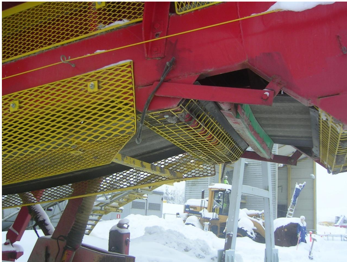
Kuva 3. Oikein tehdyt suojaukset. Kuva Mika Malinen 2011.
