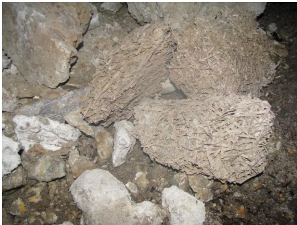
Kuvio 13. Eristeenä käytettyä lastuvillaa.
