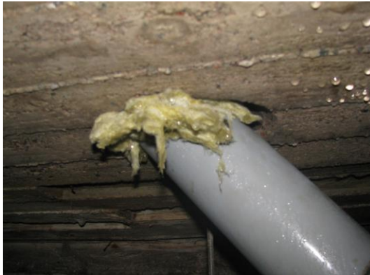
Kuvio 36. Viemäriin läpivienti.
