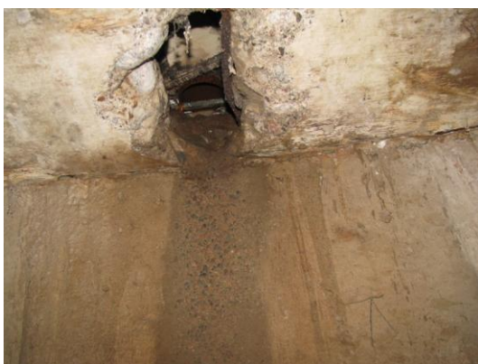
Kuvio 38. Katolle menevän tuuletusputken alapää.
