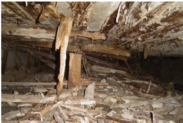
Kuvio 9. Purkamatonta muottilaudoitusta.
