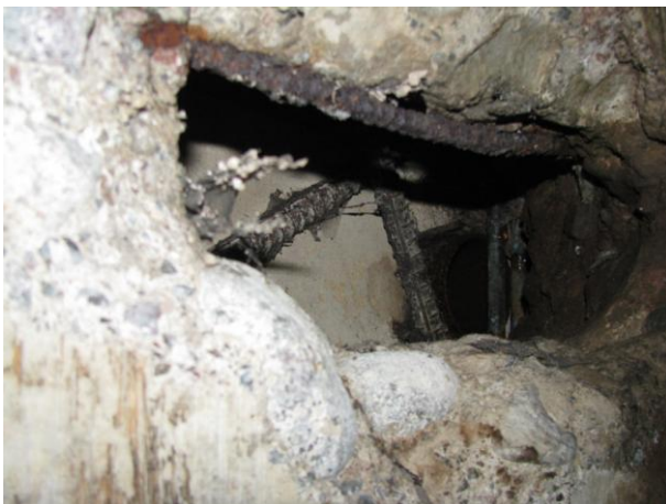
Kuvio 35. Katolle johtava tuuletusputki.
