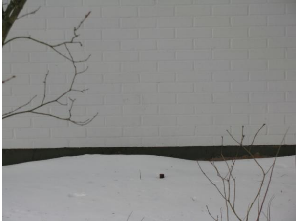
Kuvio 17. Tuulettumaton tiiliverhous.
