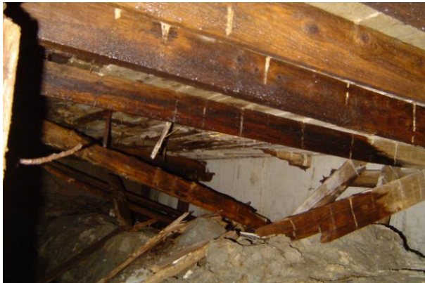
Kuvio 8. Purkamatonta muottilaudoitusta.
