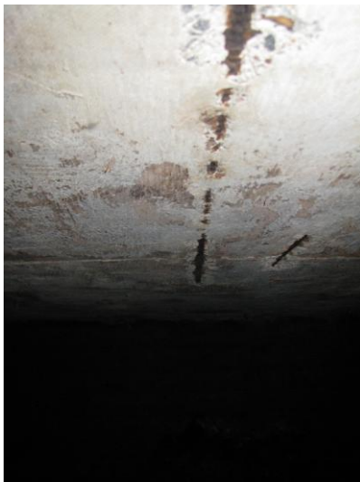
Kuvio 22. Raudoitusta alapohjalaatan alapinnassa.
