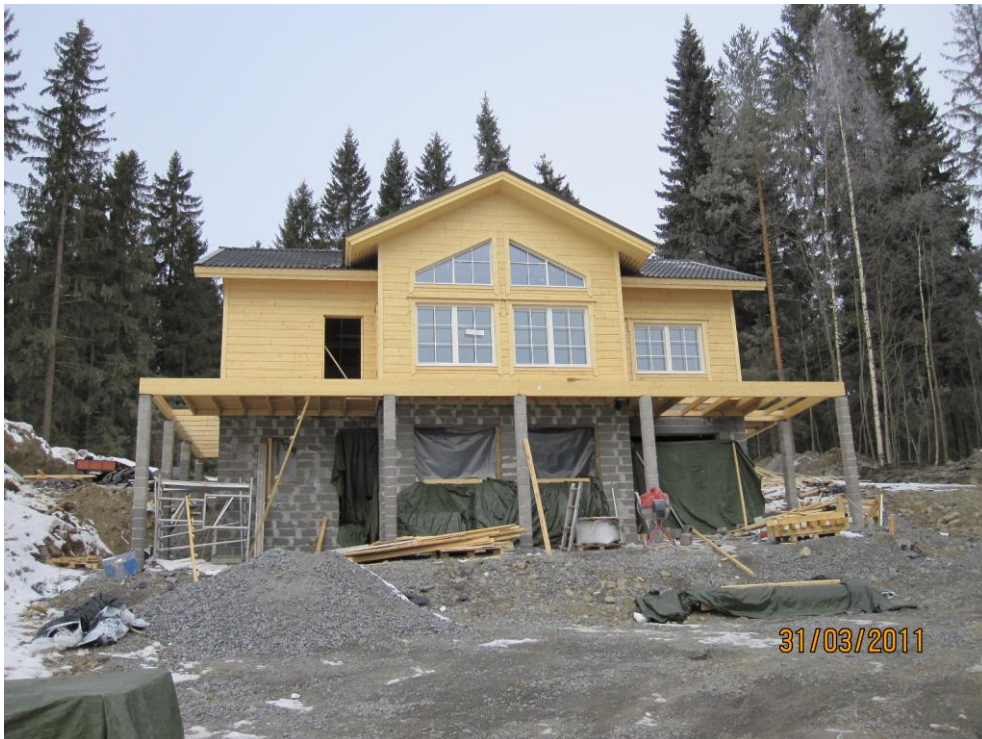
Kuva 9. Talopaketti asennettuna maaliskuun lopussa 2011.
