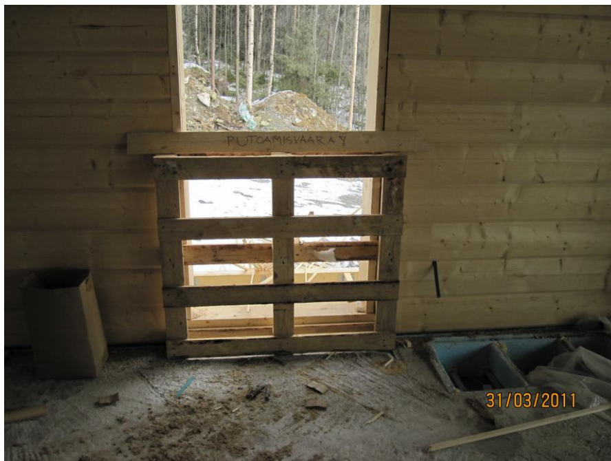
Kuva 4. Putoamissuojaus asennettuna paikoilleen.
