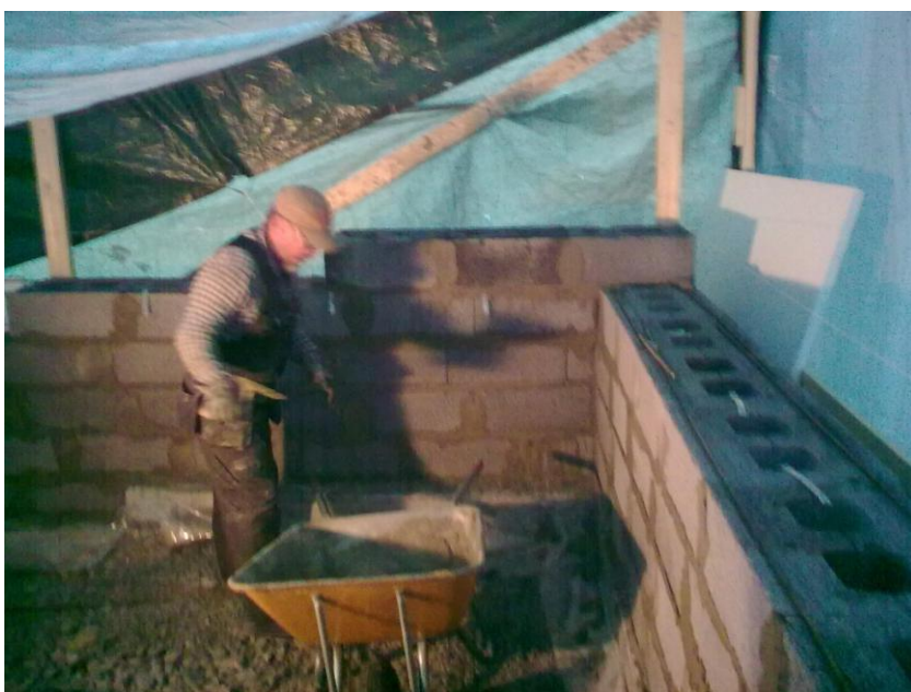
Kuva 8. Rakentamisolosuhteet teltan sisällä.
