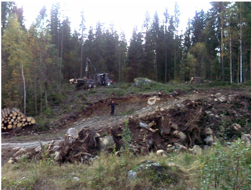
Kuva 1. Rakennusalueen tontti puuston kaatamisen jälkeen.
