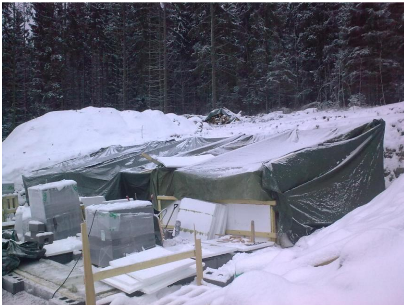
Kuva 7. Talvityön aikainen telta rakenteiden suojana.
