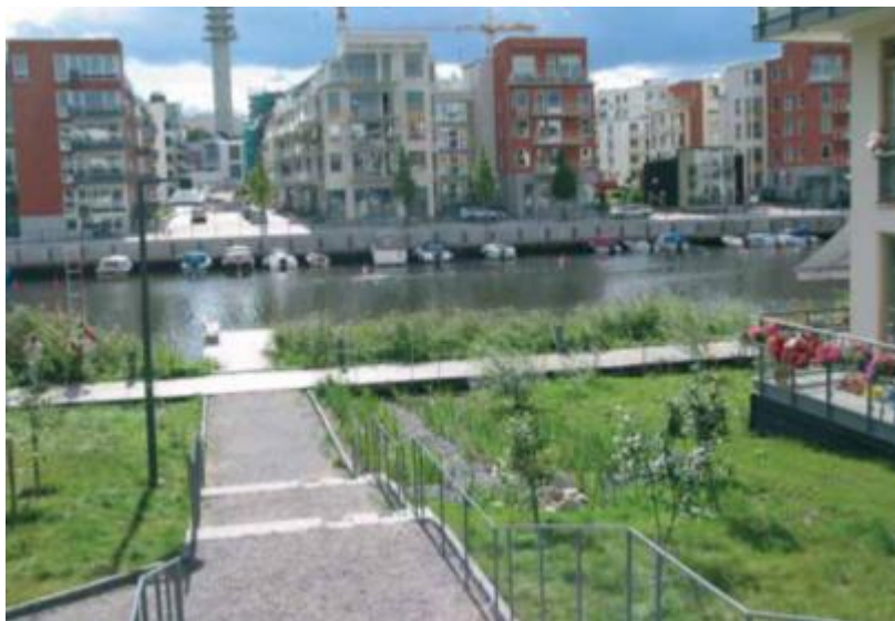
Kuva 11. Hulevesien hallintaesimerkki, Hammarby Sjöstad, Tukholma. (15).
