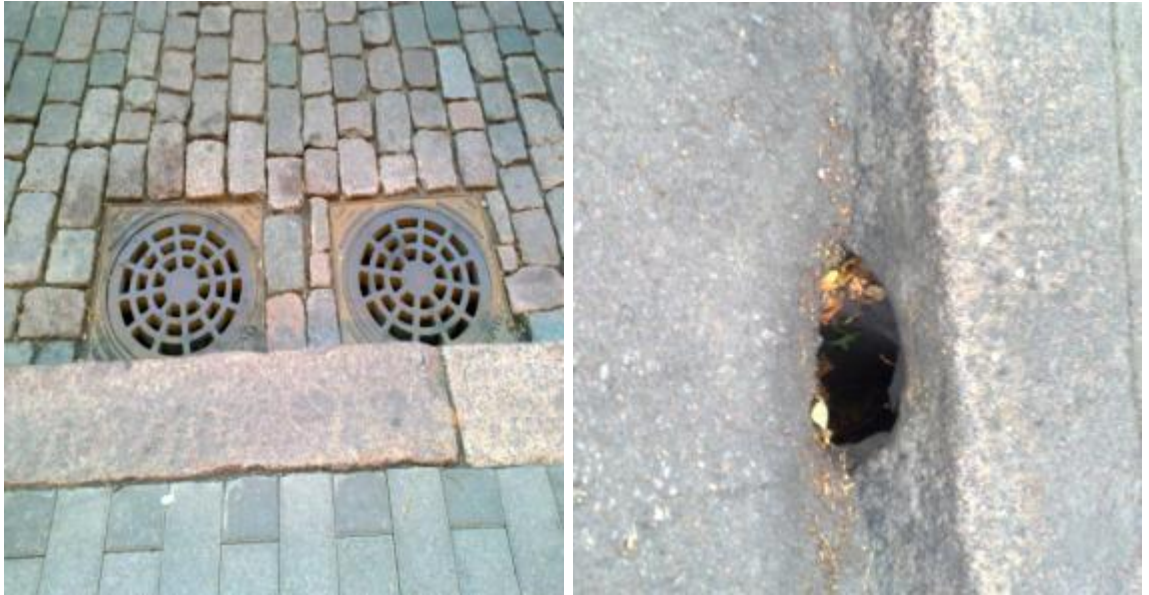
Kuva 12. Tuplaritiläkaivo Kotkassa Ruotsinsalmenkadulla, kauppakeskus Pasaatin ohi menevällä kadulla (51).
