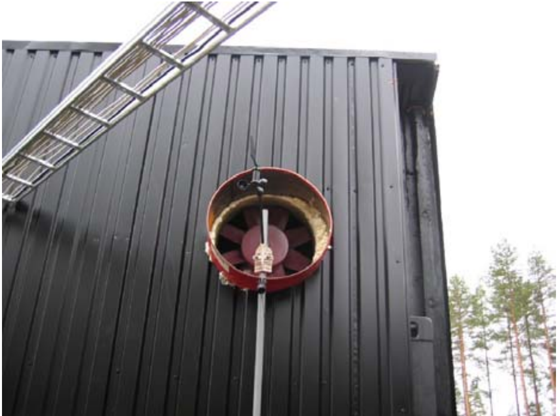
KUVIO 2. Puhallin ja tuulimittari asennettuna uudelle paikalleen.
