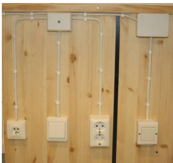
KUIVANTILAN ASENNUS
