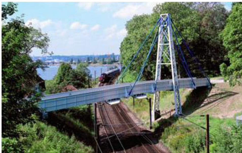
Kuva 1. Muovikomposiittisilta (Saarikivi ym. 2008, 10, Fiberline Composites).
