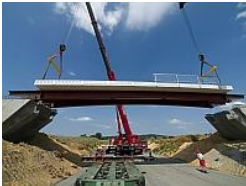
Kuva 2. Lujitemuovinen silta (Muoviteollisuus Ry, PlasticsEurope).
