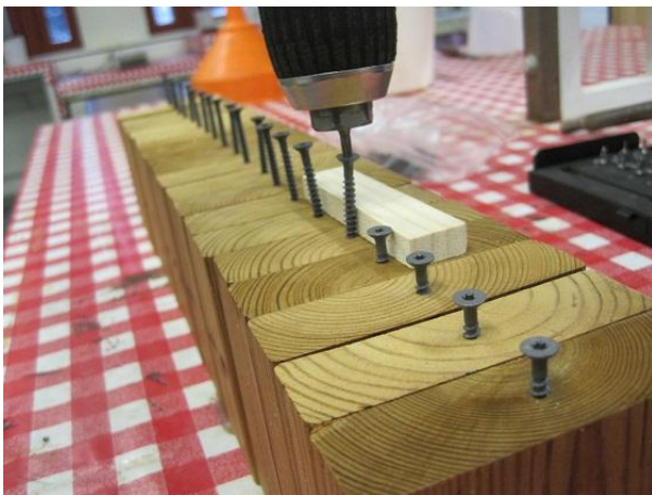
Kuva 2 Ruuvien asennus akkuporakoneella
