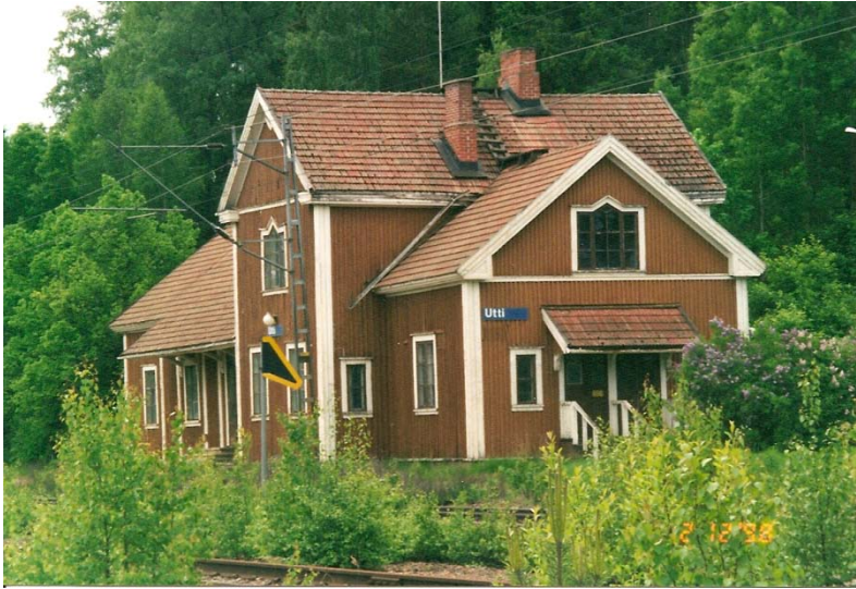
Kuva 23a. Kuvassa on Kaipiaisten aseman hirsistä rakennettu Utin nykyinen asema. Ympäristö on päässyt harmillisesti rehevöitymään (Alatalo 2010).
