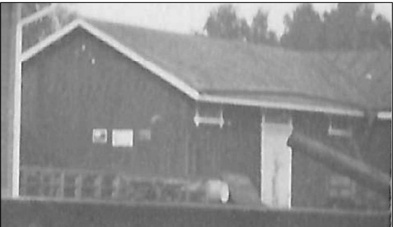
Kuva L5. Matkatavaramakasiini lounaasta katsottuna (Alatalo 2010).
