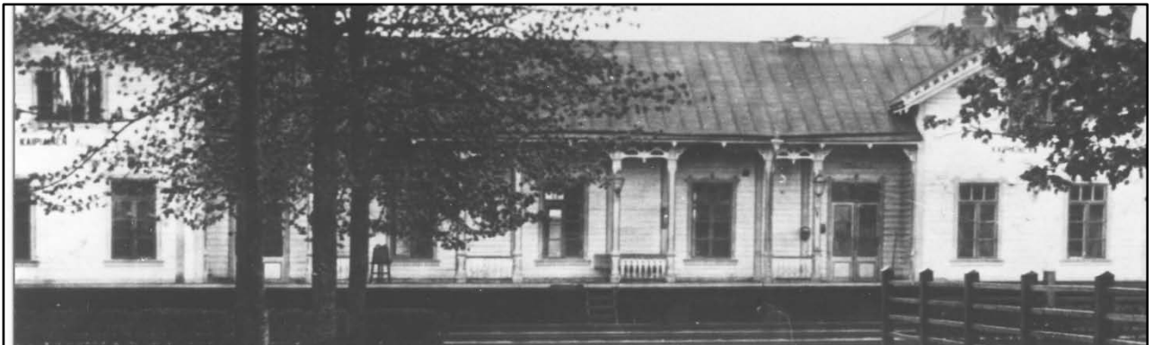
Kuva L2. Kaipiaisten rautatieasema pohjoisesta päin katsottuna (Alatalo 2010).
