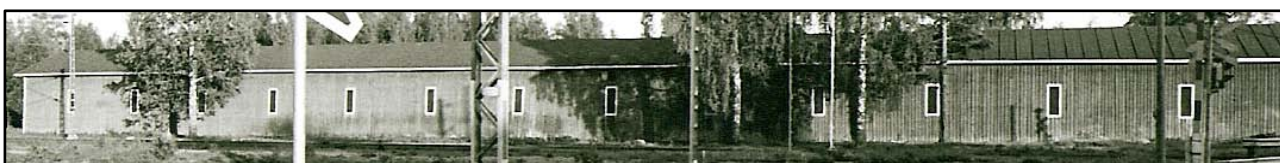
Kuva L31. Pohjoinen vaunuliiteri pohjoisesta päin kuvattuna 1970-luvulla. Ikkuna-aukkojen määrä on puolittunut kunnostuksen yhteydessä (Alatalo 2010).
