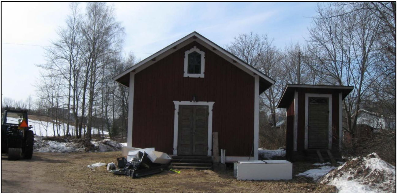
Kuva L44. Ulkorakennuksen takana on ulkovessa (Karhu 2010).
