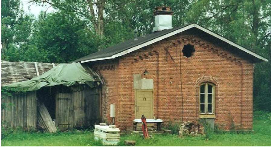
Kuva 55. Valokuva pumppuasemasta. Täältä pumpattiin vesi veturivarikon konttoriosan vesitorniin (Alatalo 2010).
