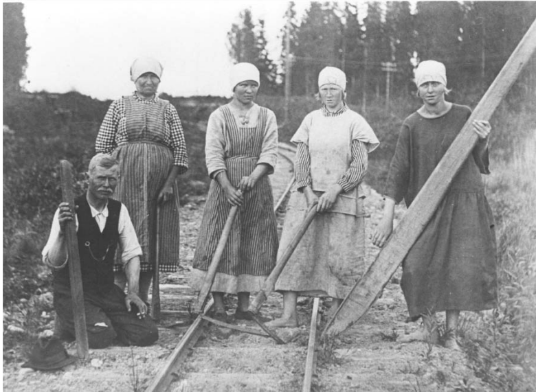
Kuva 10. Poikkeuksellisesti pääosin naisista koostuva topparoikka Kaipainen-Tirva -rataosuudelta. Topparoikka tarkoittaa ratatyöryhmää (Tuntematon).
