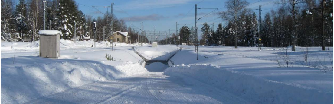
Kuva 26. Ajotie alikulkutunneliin. Vanha WC-rakennus sijaitsee tunnelin suun kohdalla (Karhu 2010).
