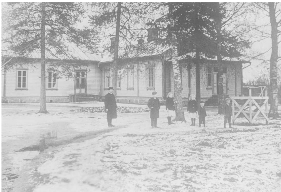
Kuva 54. Valtionrautateiden kansakoulu Kaipiaisissa. Ikkunakoristelu ja graniittisokkeli ovat perinteistä rautatietyyliä (Tuntematon).
