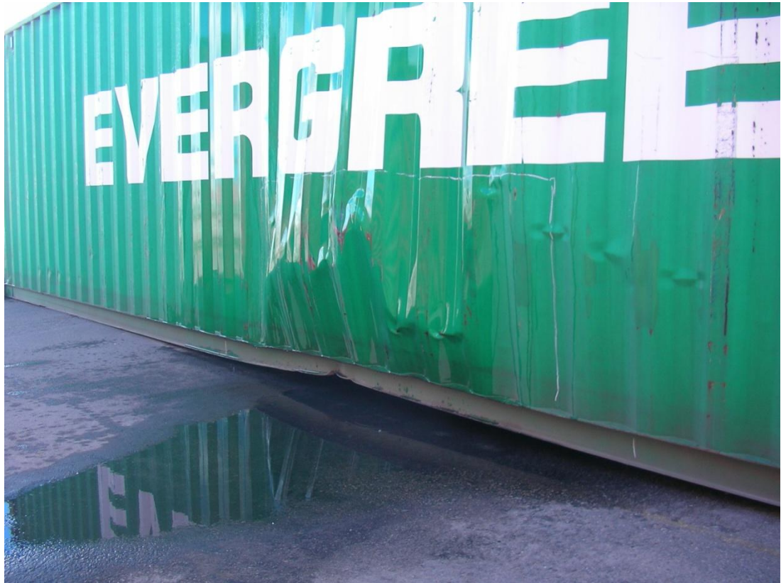
(Kuva 3. Kontin seinä taipunut ulospäin.)
