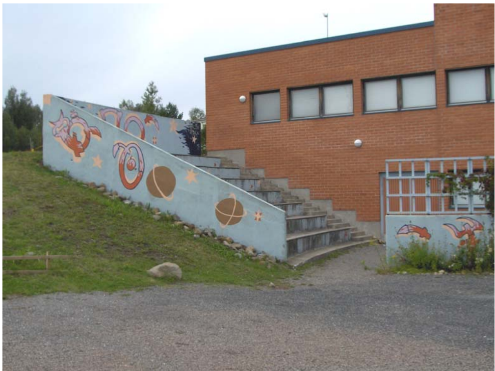
Kuvio 20. Ränsistynyt ulkoauditorio aukeaa pohjoiseen (Inventointikuvat, 2007).
