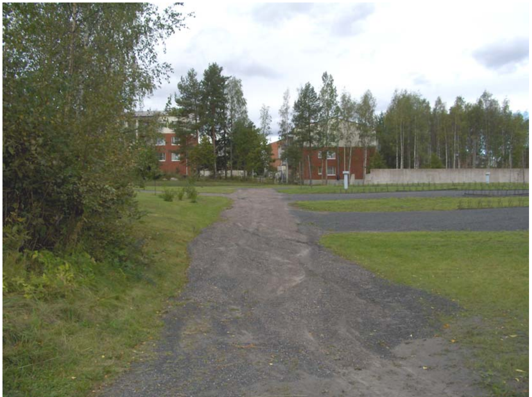
Kuvio 23. Sorapäällysteiset kulkuväylät voivat olla turvallisuusriski, koska eroosion aiheuttamat urat pinnoitteessa ovat syviä (Inventointikuvat, 2007).
