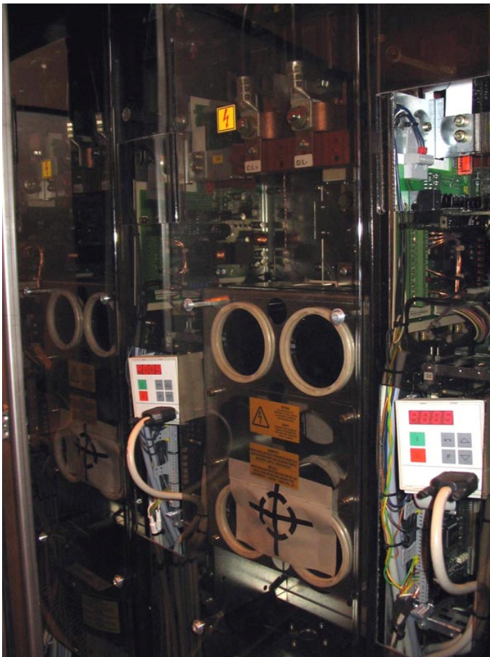
Kuva 10 Ajomoottorin invertteri EU 440 -sähkökaapissa
