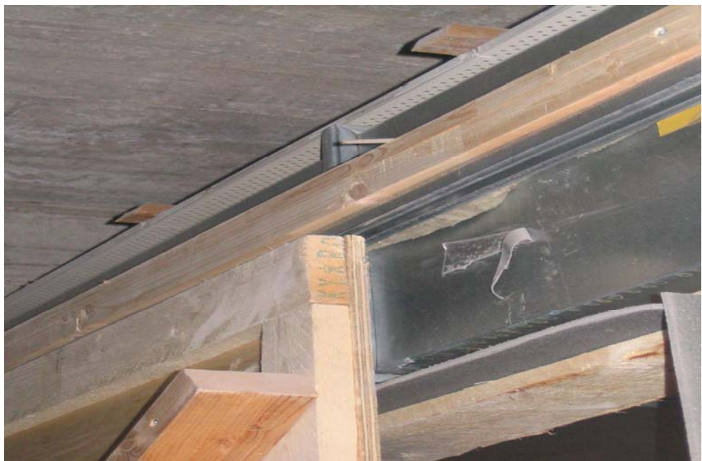
Kuva 8. Liukuovi kiskon kiinnitys suojaseinään
