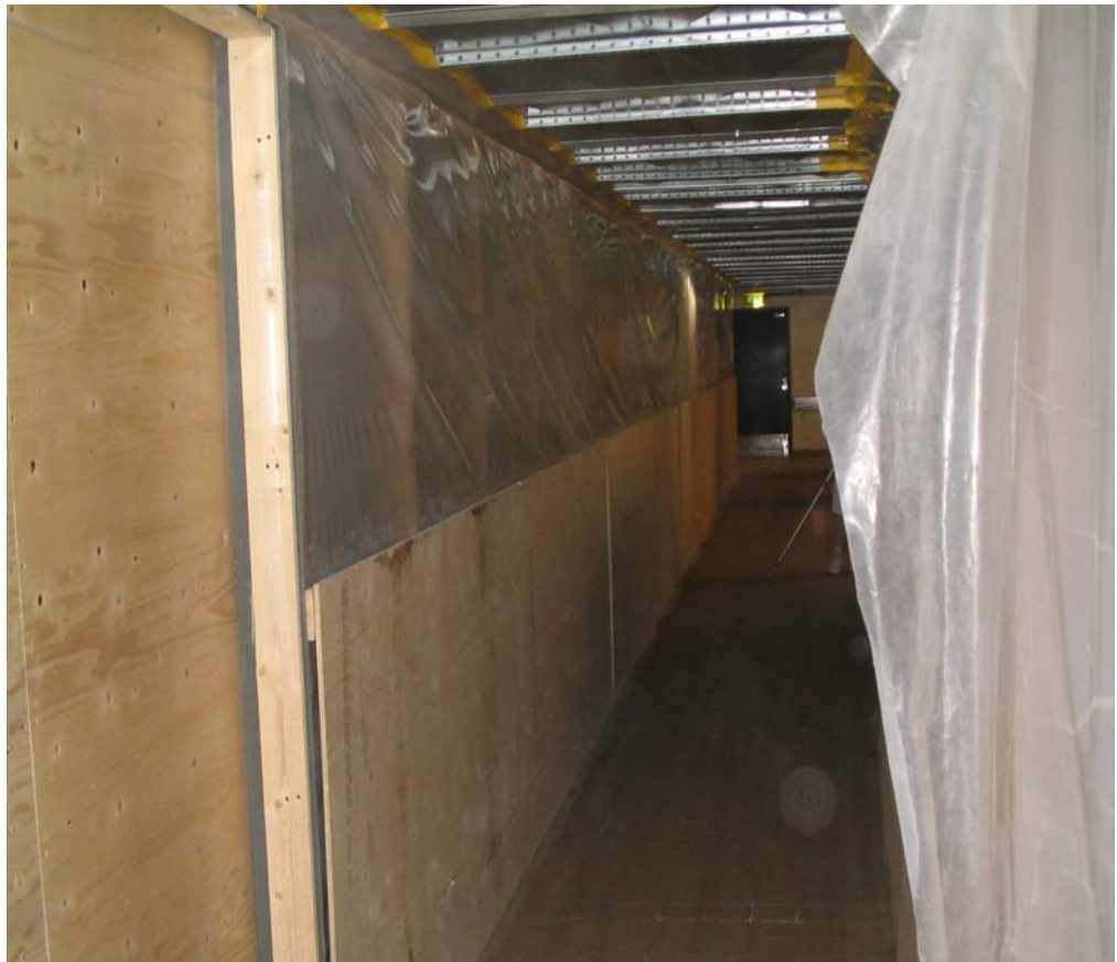
Kuva 6. Vanerilla vahvistettu suojaseinä
