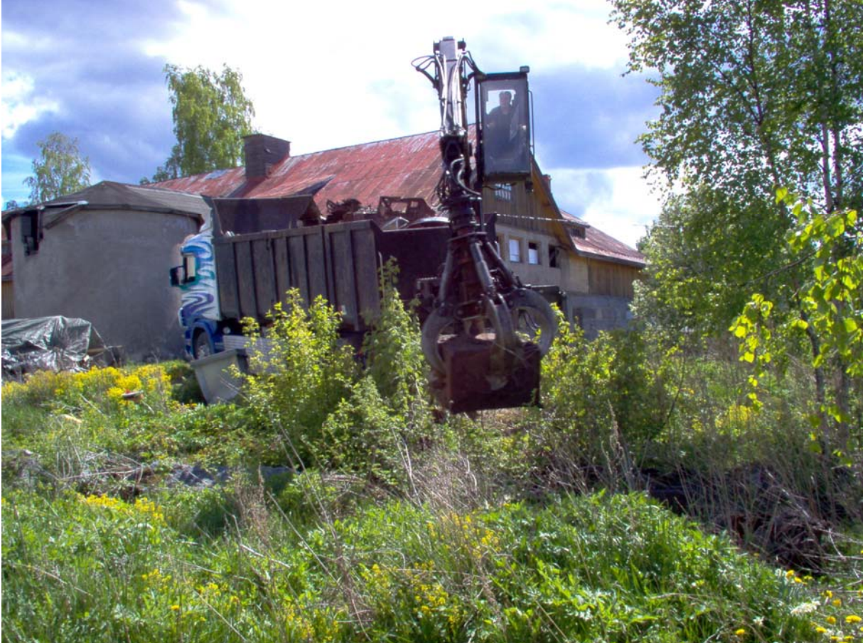
Kuva 5. Navetan pihan siivoamista vanhoista metalliromuista.
