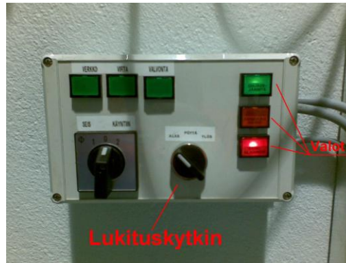
Kuva 4. Hydrauliikan ohjauspaneeli ja huomiovalot koekäyttötilassa
