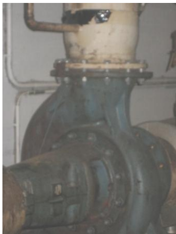
Kuva 9. Laivauksessa käytetty keskipakopumppu.
