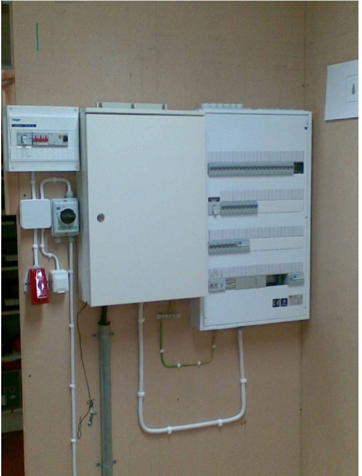
Kuva 12. Esimerkkitehtävässä käytettävät pääkeskus PK1 ja ryhmäkeskus RK1
