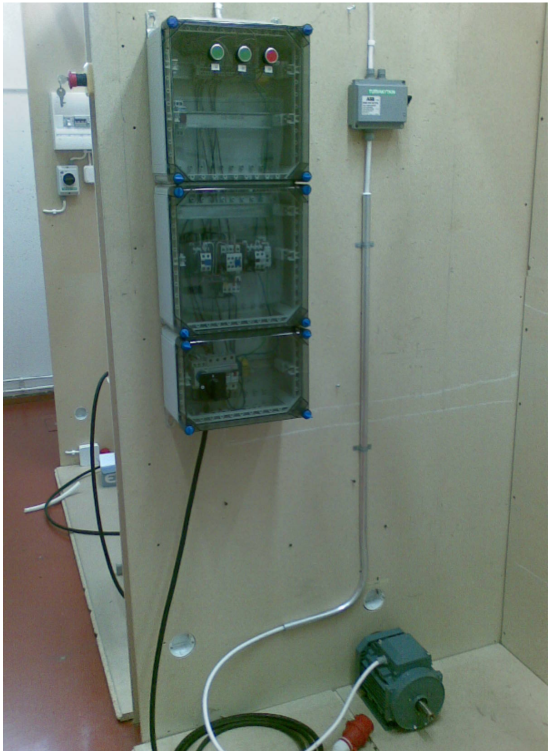
Kuva 6. Esimerkki moottoriasennusharjoituksen lopputuloksesta
