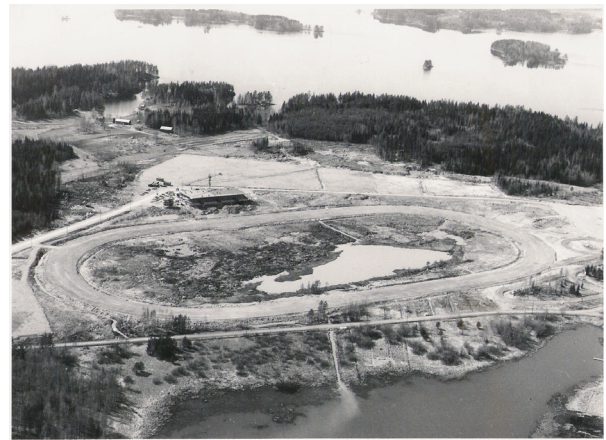
Ilmakuva Kuopion raviradan rakennustöistä Sorsasalossa.
