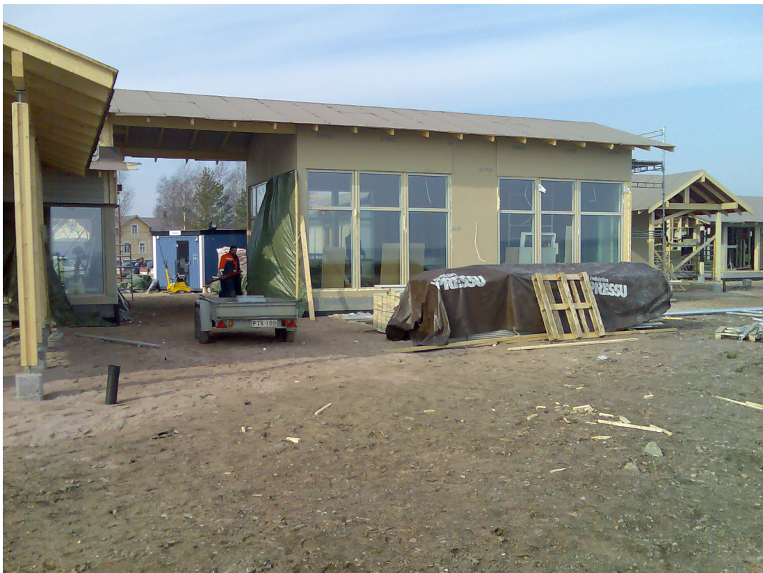
Kuva 4: Rakennus sisävalmistusvaiheessa, mereltä päin kuvattuna, huhtikuu 2008.
