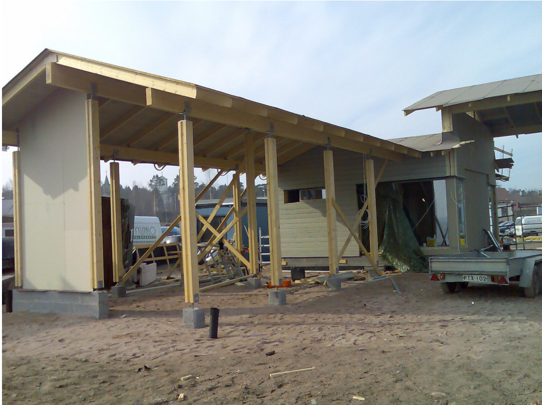
Kuva 5: Oleskelukatos ja saunarakennus, huhtikuu 2008.
