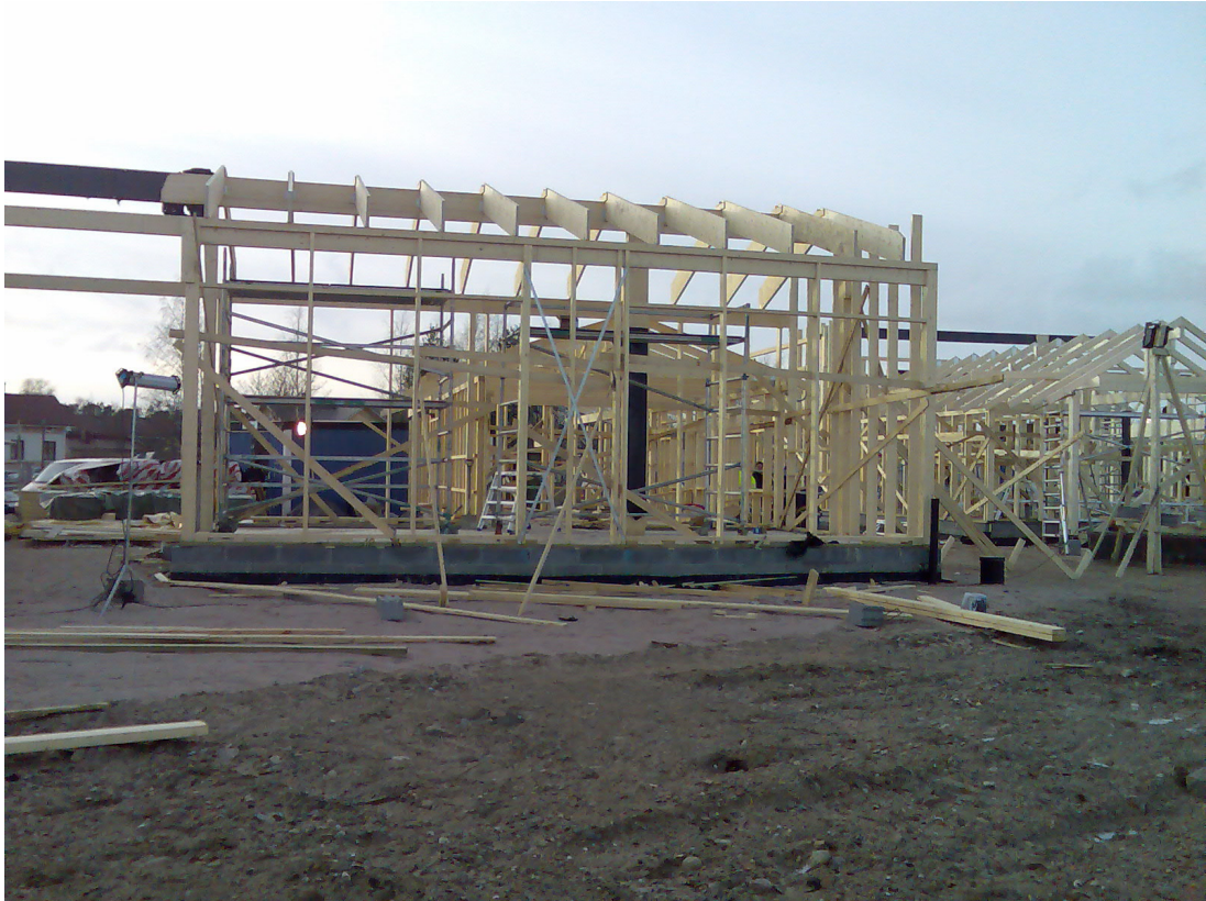
Kuva 3: Päärakennus runkovaiheessa, helmikuu 2008.
