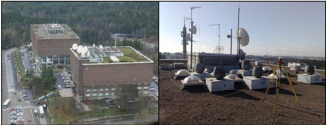
Kuvat 31 ja 32. Mittaus tapahtui vasemmassa kuvassa kauempana näkyvän vesitornin päällä [32]. Oikeanpuoleinen kuva on otettu vesitornin katolta.
