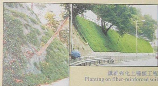
植生吹附工法 Hydro-mulching
