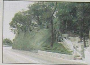
加上顏色的噴漿 混凝土護面 Coloured shotcrete
