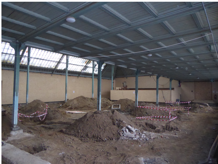
Figuur 24: Toestand van het terrein na de verwijdering van de vloer en na de eerste graafwerken op 04/07/2017 (©agentschap Onroerend Erfgoed: Geert Vynckier).
