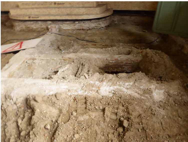
Figuur 34: Muurfundering spoor S15 (©agentschap Onroerend Erfgoed: Geert Vynckier).
