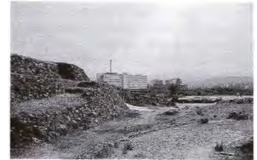
Figura 3. Nodo Insurgentes-Periférico Sur el conflicto entre la historia y la modernidad (Foto Armando Serrano)
