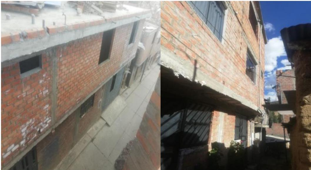
***Figura 20: Elevación frontal de discontinuidad de la vivienda***
