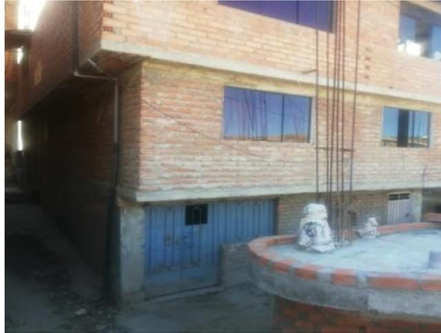
**Figura 5: Elevaciones inapropiadas.**
