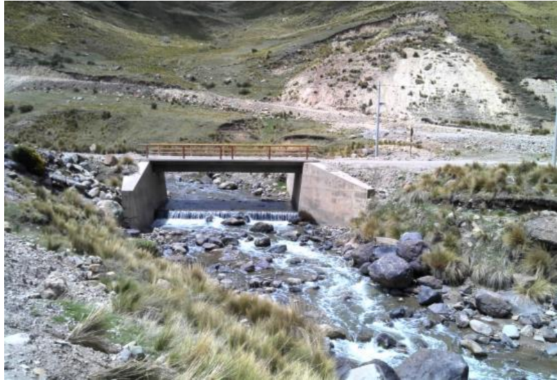
Figura1 Puente Lucas Chacana P.K. 62+260
