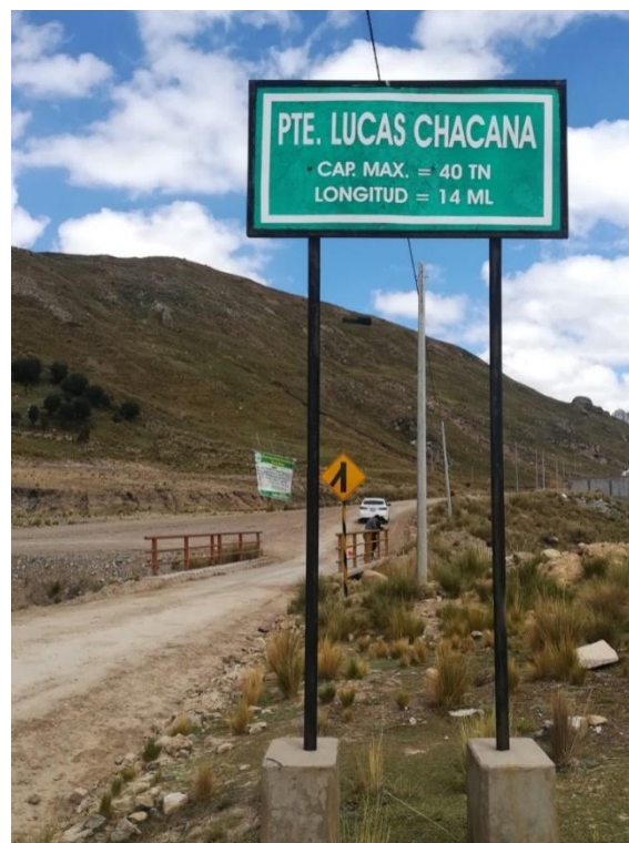
Figura 4 Vista general del puente. Fuente: Elaboración propia
