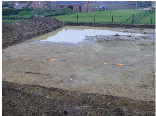
Fig. 11. De toestand van het zuidelijk deel van de werkput op 4 december 2013.
