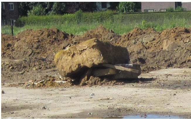
Betonnen funderingsblok van één van de houten spanten van de hal.
