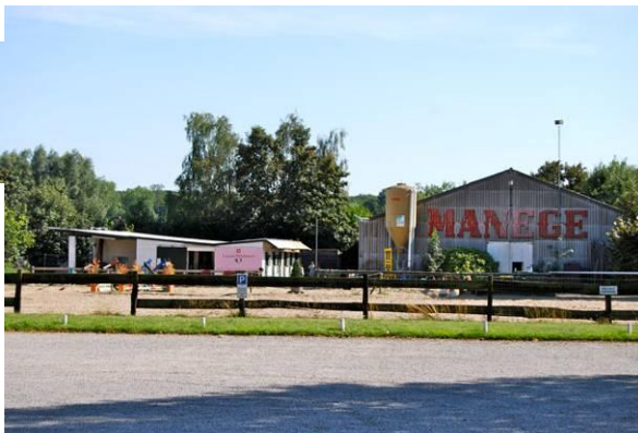
De voormalige overdekte manège en aanhorigheden gezien vanaf de parking aan de Leuvensesteenweg. Links (oost) van de overdekte hal staan een aantal stallingen.
