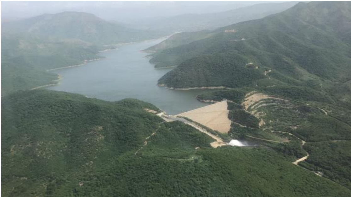
Figure 17. Aerial view of the Cercado Dam Source : Procuraduría General de la Nación https://twitter.com/PGN_COL/status/1012010015757144064
