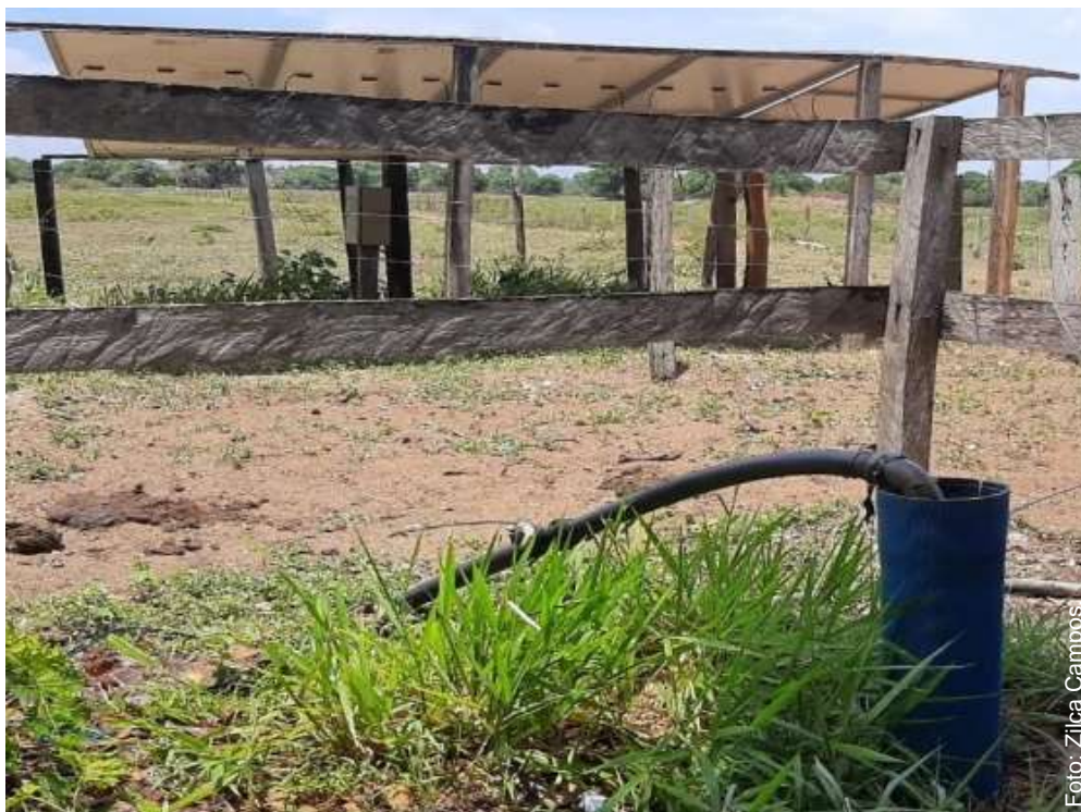
Figura 7. Sistema implantado em fazenda do Pantanal mostrando o poço e as placas solares fotovoltaicas.
