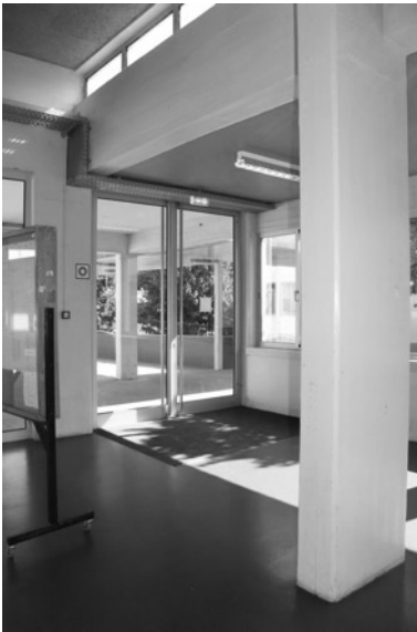
fig. 30_ Entrada do bloco principal da escola secundária Garcia de Orta.
