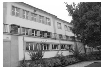
fig. 25_ Fachada da escola secundária Carolina Michaelis.
