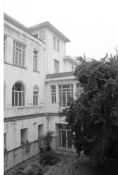
fig. 24_ Fachada tardoiz da escola secundária Rodrigues de Freitas.
