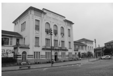
fig. 97_ Escola secundária Rodrigues de Freitas.
