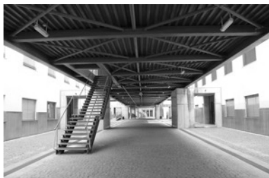
fig. 88_ Espaço de circulação coberto.
