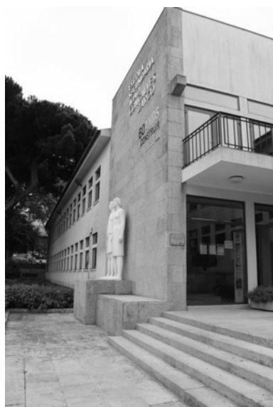
fig. 59_ Entrada da escola secundária João Gonçalves Zarco.
