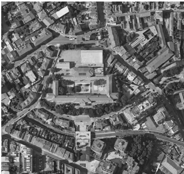
fig. 48_ Implantação da escola secundária Carolina Michaelis depois da intervenção da Parque Escolar.
