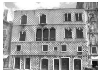
fig. 7_ Fachada principal da Casa dos Bicos (Casa de Brás de Albuquerque), após a intervenção.
