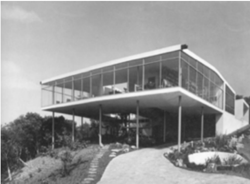
12. Casa de vidro
